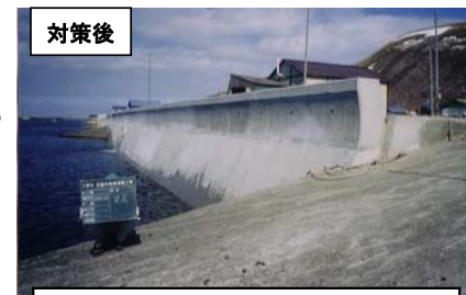
前腹付けによる老朽化対策後の護岸
