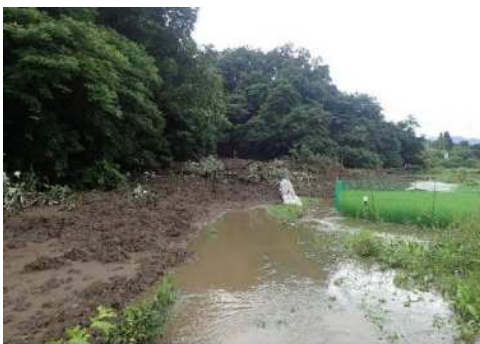
応急対策工事前
