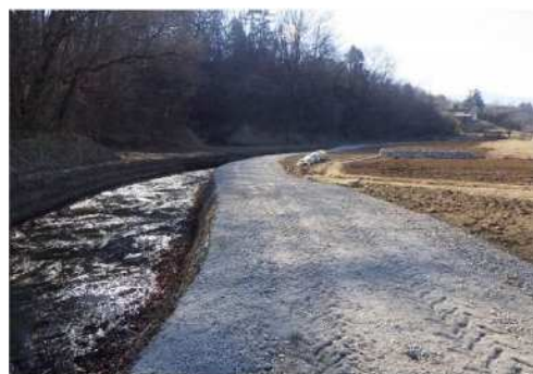
応急対策工事後（流出土砂の撤去）
