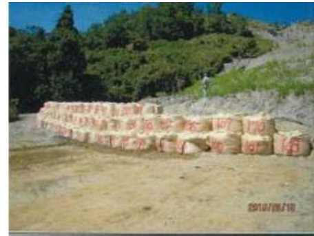
応急対策工事後（大型土嚢）
