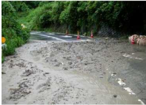
崩落発生後（国道への土砂流出）
