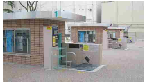
▲公園を利用した地下自転車等駐車場
