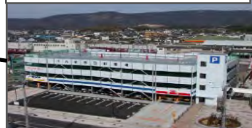
駐車場・駐輪場の整備
