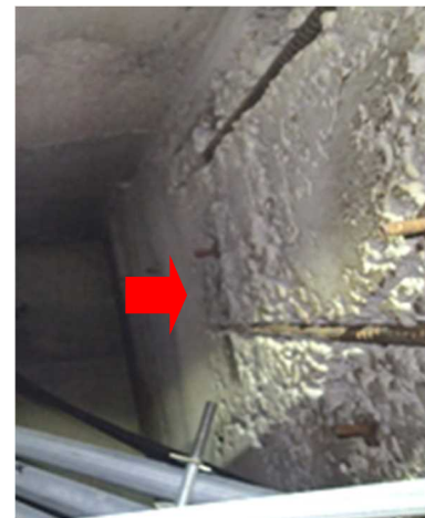
ジャンカ、鉄筋の露出
