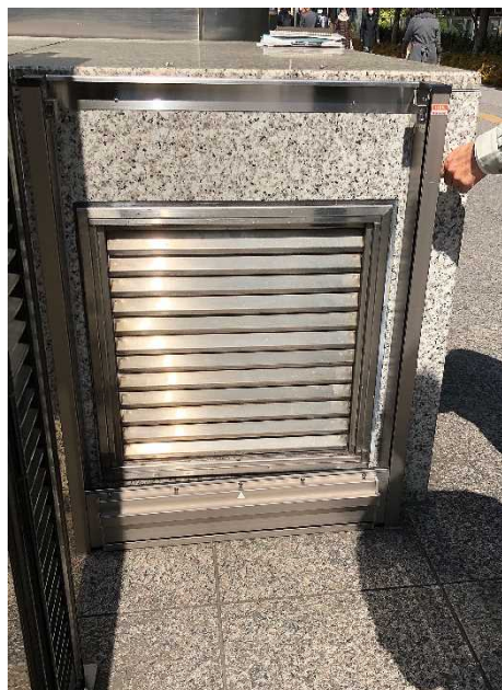
止水板設置前(換気口)
