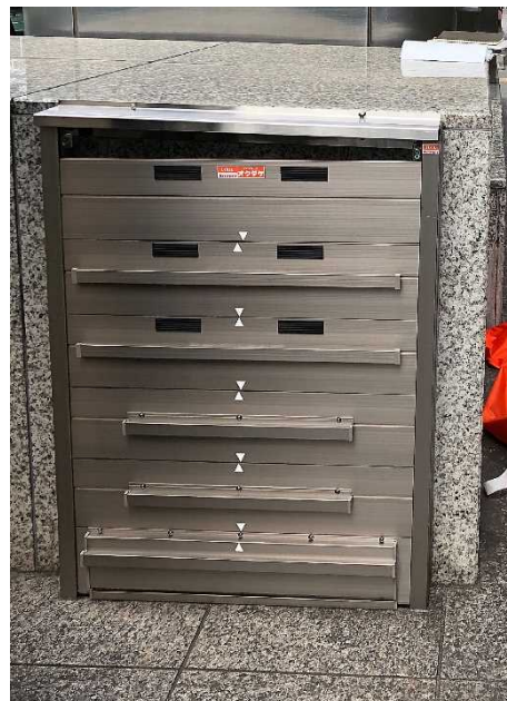
止水板設置後
