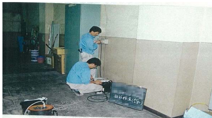
写真 3-2-9 電磁波による鉄筋調査
