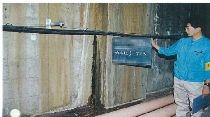
写真 3-2-3 漏水調査状況
