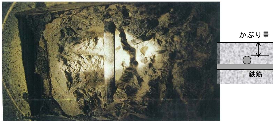
写真 3-2-8 鉄筋露出調査状況
