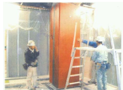
施工写真 (⑥鋼板建込み)
