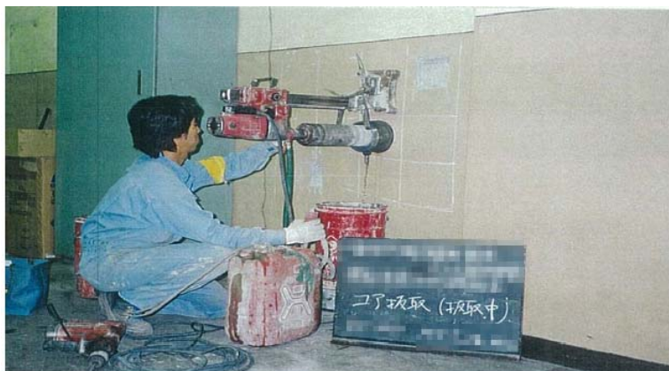
写真 3-2-4 コンクリートコア(試料)採取状況
