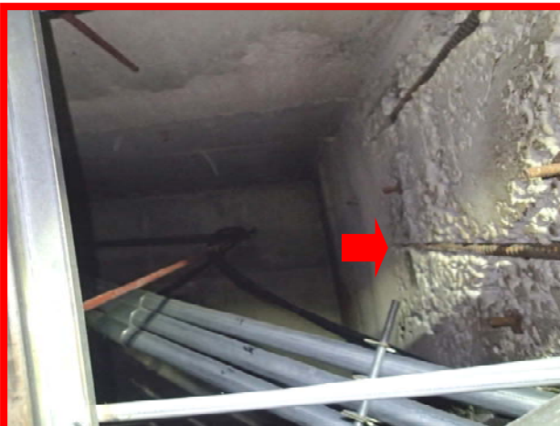
ジャンカ、鉄筋の露出
