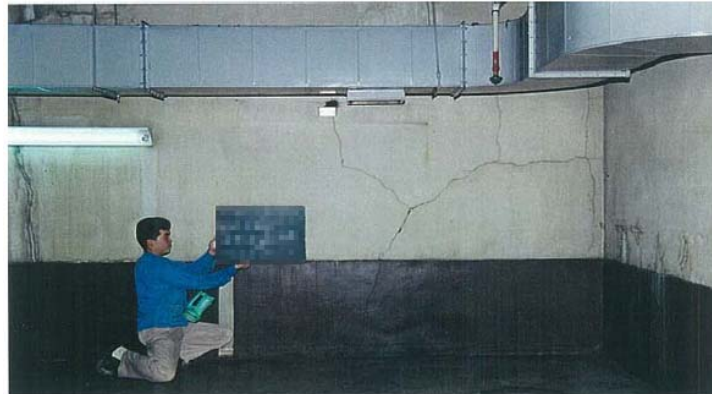
写真 3-2-1 ひび割れ調査状況
