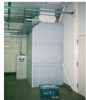
③化粧板取付け
