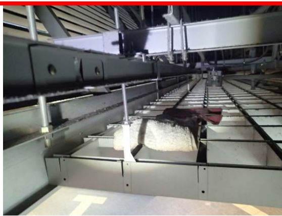
漏水応急措置のルーバー上タオル
