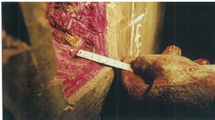
写真 3-2-7 フェノールフタレイン試薬による中性化試験(赤く染まった部分がアルカリ性)
