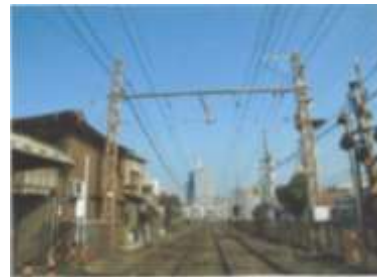
整備された電車線
