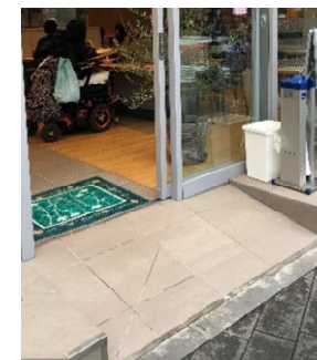
スロープの設置
