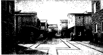
コスモエニシアが東京都大田区に分譲地で手付けた無電柱化。専区画の敷地延長部分全体に地役権を設定し地中に電線を埋め込んだ。自治体電線の電線共同溝ではなく同社独自の基礎的な無電柱化を実現
