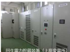
回生電力貯蔵装置（上原変電所）
