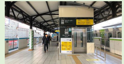
バリアフリー設備整備 (エレベータ)
