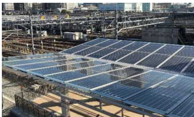
【ホーム屋根部】
