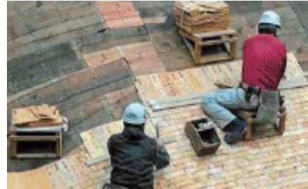
奉納された土居葺板を屋根下地に(同左)
