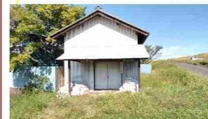
②笠松水防倉庫 (木曾川右岸地帯水防事務組合)
