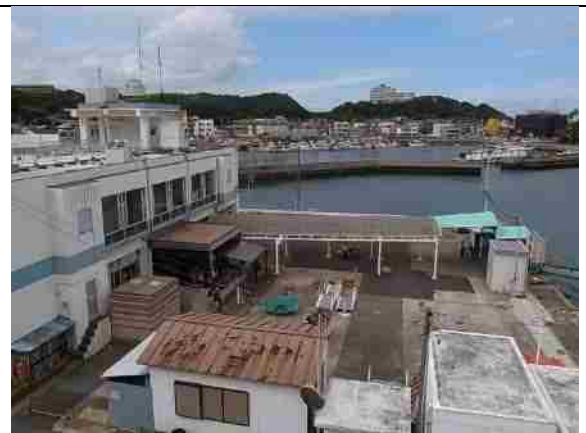
観光センター(海側) 浄化槽などが確認できる
