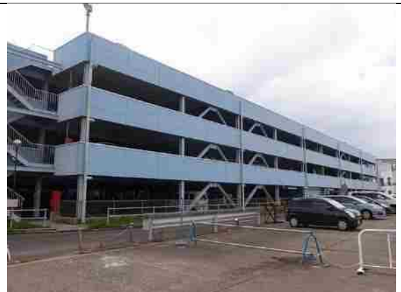
立体(第2)駐車場
