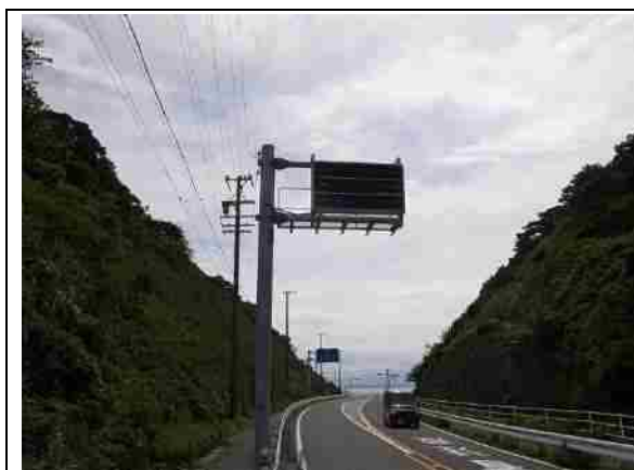
師崎港交差点北側手前に設置された LED 表示器
