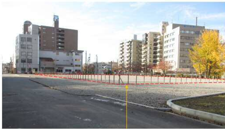
対象敷地（仮設の柵で囲まれている）
