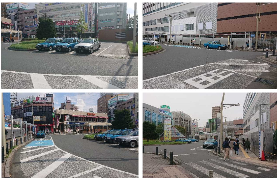
図 3-3-19 南口タクシープール、タクシー乗降場
