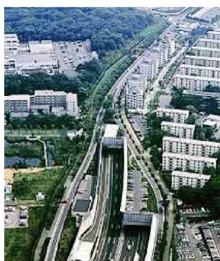
西大和団地全景
