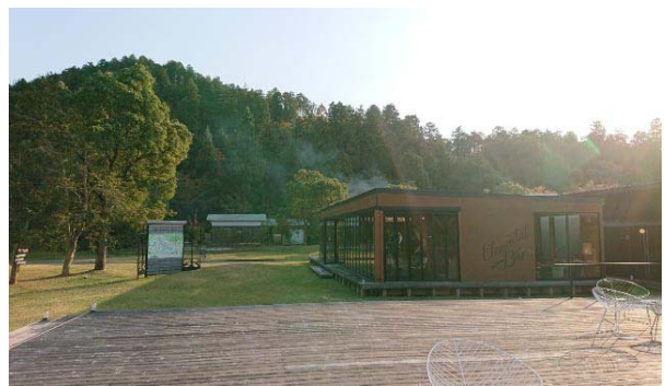
⑧管理倉庫（奥の建物）
