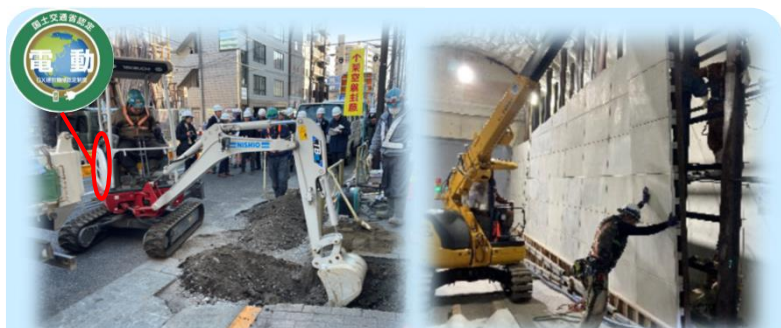
GX建設建機による施工
