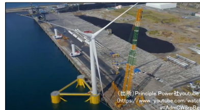
浮体式洋上風力発電施設の港湾利用のイメージ(スペイン フェロル港)
