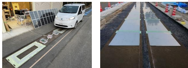
コイル・電極の舗装埋設による給電試験の様子 (左: 東京理科大学居村研究室、右: 大成建設)
