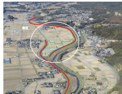
▲霞堤整備事例
