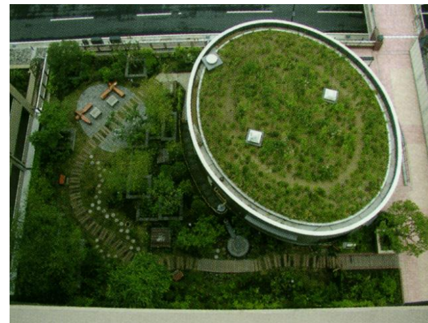
屋上ビオトープ
