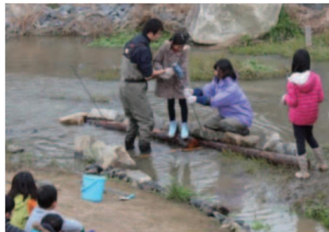
間伐材水制施工時の様子
