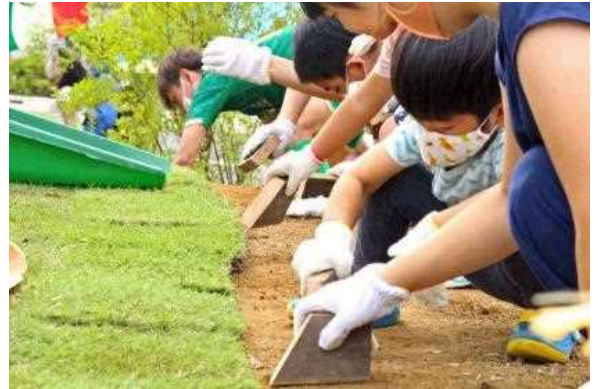
芝張り工事体験；お庭を住民参加型の施工で仕上げた
