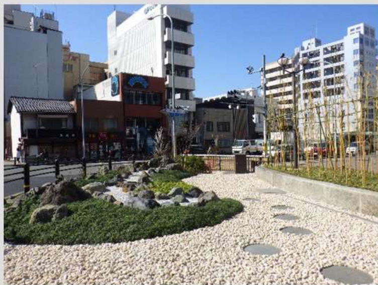
令和元年度 雨庭整備（交差点北西角）
