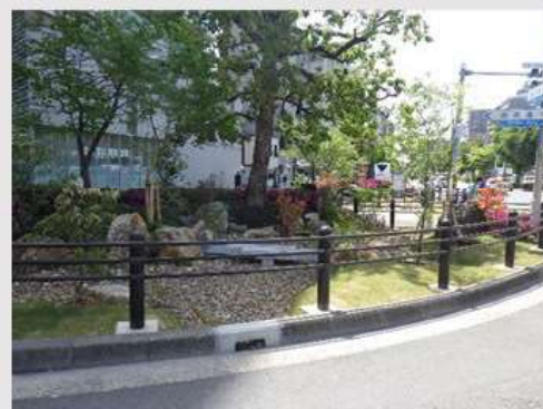
穴あき歩車道境界ブロックの設置状況
