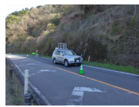
MMS※1を活用した 斜面・のり面点検
