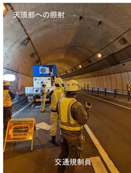
図-6.7.1 レーザー打音検査装置のトンネル天頂部への照射状況
