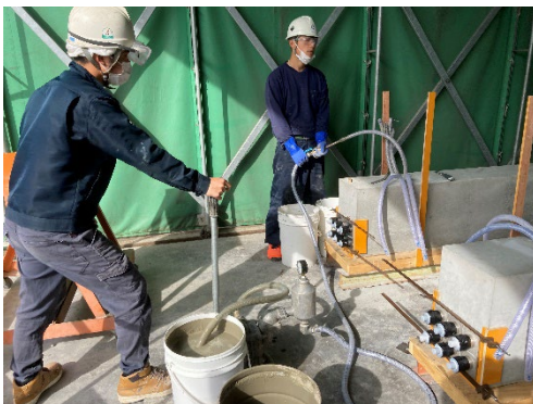
写真-12 グラウトの注入作業
