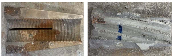
(a) 普通鋼N-5 (b) SUS420J2鋼N-5 写真-17 N供試体ウェッジ内側の腐食状況
