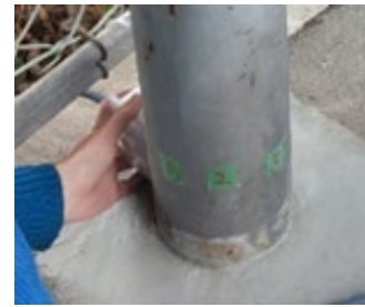
図 2. 地際用センサプローブを用いた標識柱地際下の検査
