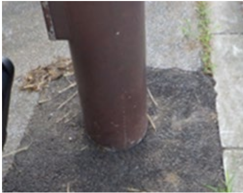
図 3.2-18 ELECT で計測した照明柱の一例
