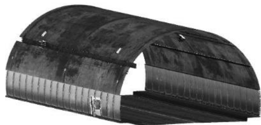
図-19 生坂トンネル三次元点群データ
