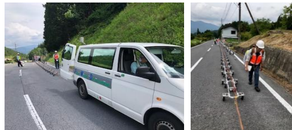
写真 4.8 ハイブリッド計測の様子 (左:FWD試験車両と2次元表面波探査, 右:牽引式電気探査)
