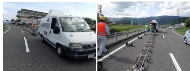
写真 2.3 FWD に牽引される測定台車（2次元表面波探査用受振器と牽引式電気検層を並列牽引）
