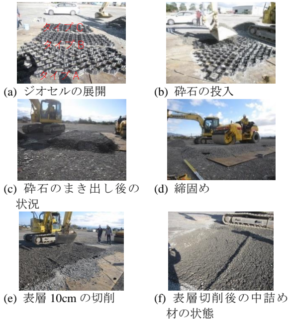
写真 4.24 締固め試験の状況
