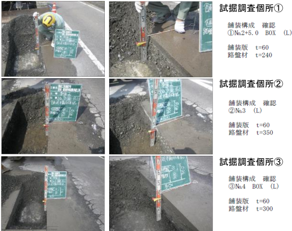
図 4.5 修繕前の試掘調査(①平輪橋側 BOX 上, ② BOX との間, ③BOX 直上)
