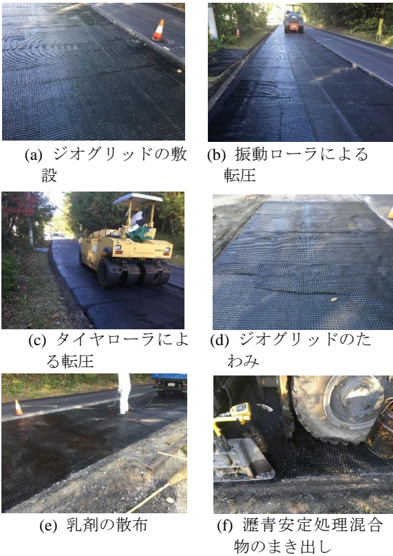
写真 4.12 上り線の施工状況（その1）
