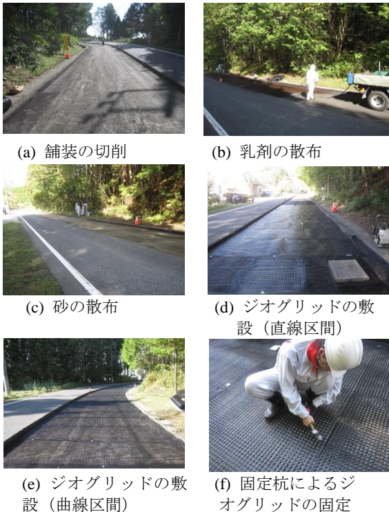
写真 4. 10 下り線の施工状況 (その 1)
