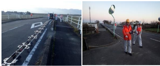
写真 4.3 修繕前のハイブリッド計測の作業状況
