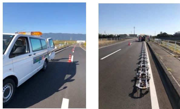
写真 4.4 修繕後のハイブリッド計測の作業状況
