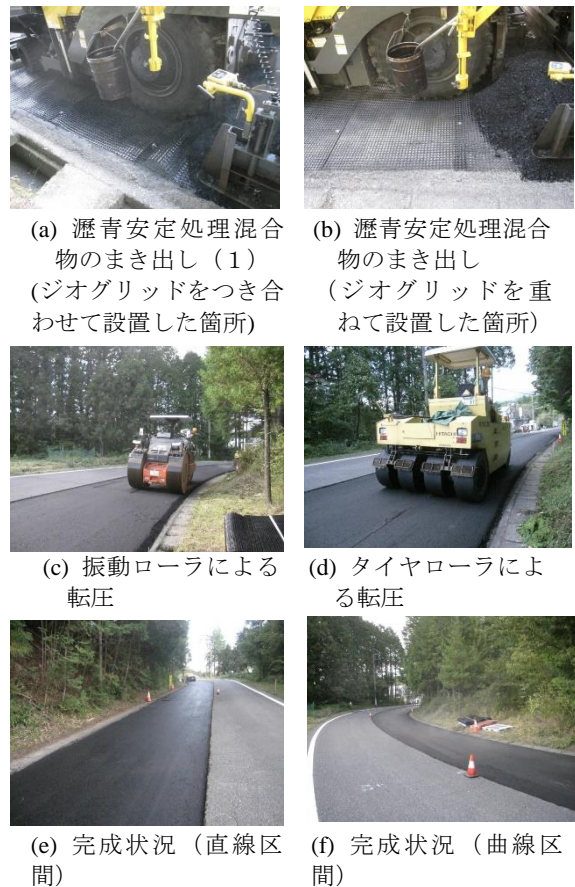
写真 4. 11 下り線の施工状況 (その 2)
