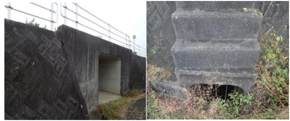
写真4.1 路面直下のボックスカルバート・函渠
