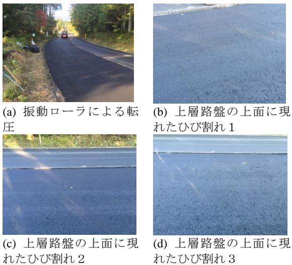
写真 4.13 上り線の施工状況（その2）
