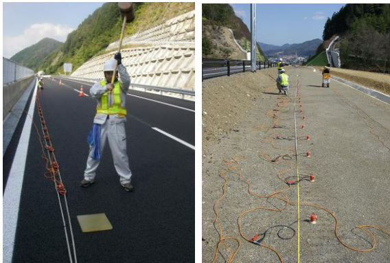
写真2.1 2次元表面波探査の測定状況(左：ランドストリーマー、右：一般的な手法)
