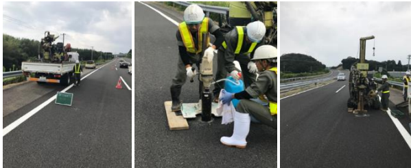
写真 4.6 ボーリング作業状況 (左; 採取位置, 中央; コアドリル, 右; コアボーリング)
