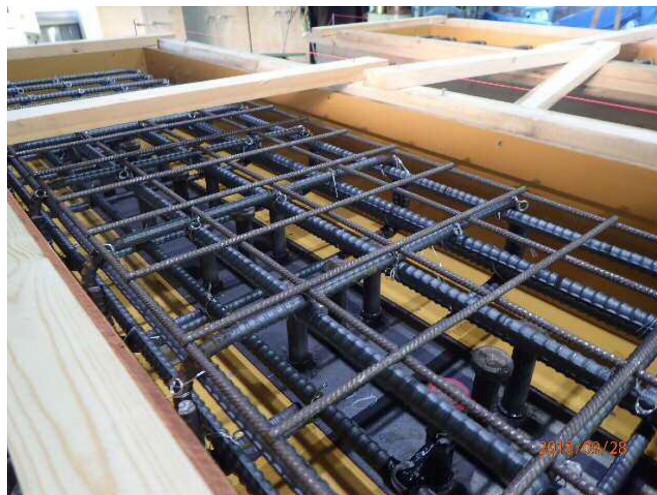
図 2-6 鉄筋格子 (SD295, D6)
