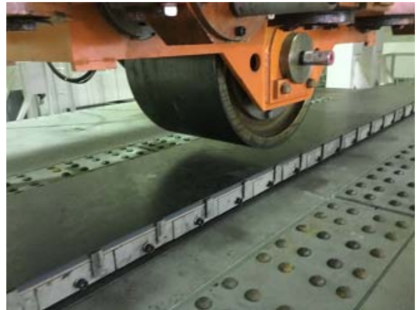
図5-25 輪荷重載荷部位（設置完了）
