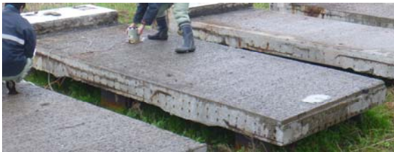
写真-3 撤去床版の局所振動試験の状況
