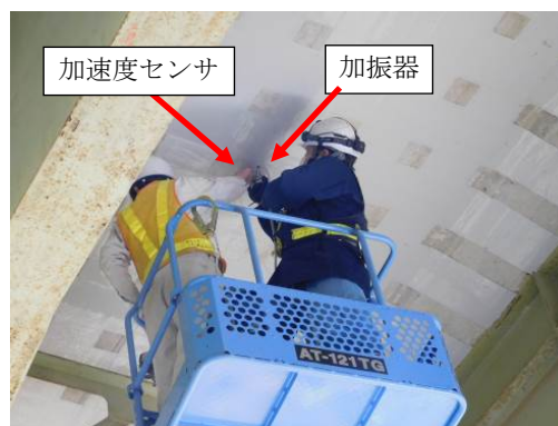
写真-18 測定状況 (炭素繊維シート上)
