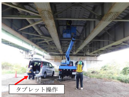
写真-17 対象橋梁 B の外観
