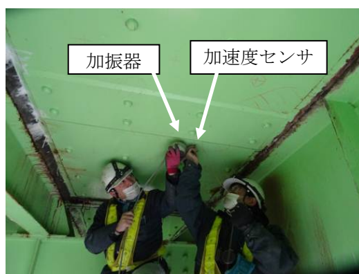
写真-16 床版下面からの測定状況
