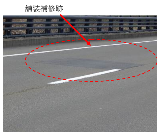
写真-22 橋面の状態 (0304)
