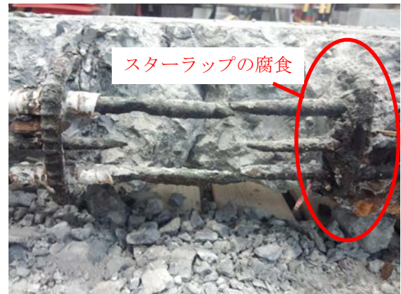
写真-7 K20 供試体の解体状況
