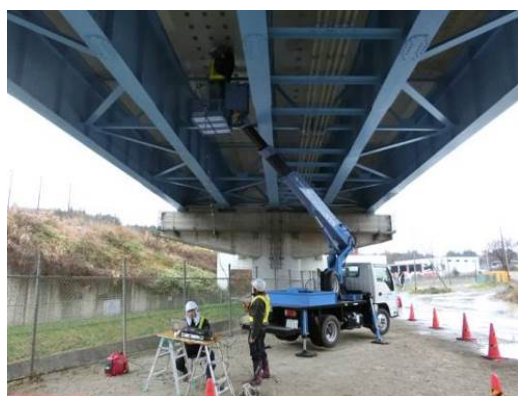
写真-19 対象橋梁 C の外観
