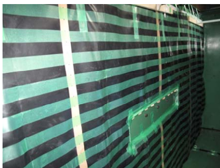
(d) シートを壁面に設置 写真3-4 摩擦軽減の処理
