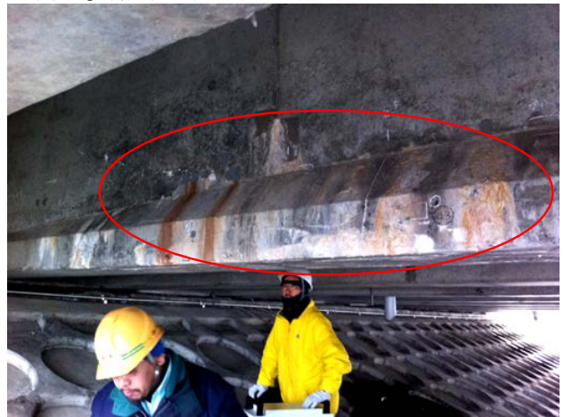
図 3-9 供用 20 年コンクリート橋の外観調査 (山形県内)
