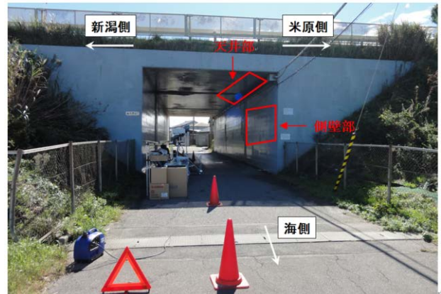
Photo. 4.2 実験風景 (側壁部探查時)
