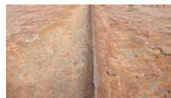
図 2-20 垂直補剛材近傍の腐食減厚特性
