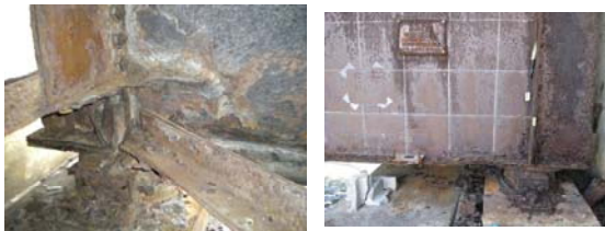
a) 支点部(内面側) b) 支点部(外面側) 写真2-4 支点部の腐食状況
