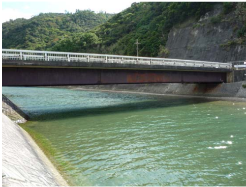
写真 4-1 対象橋梁全景
