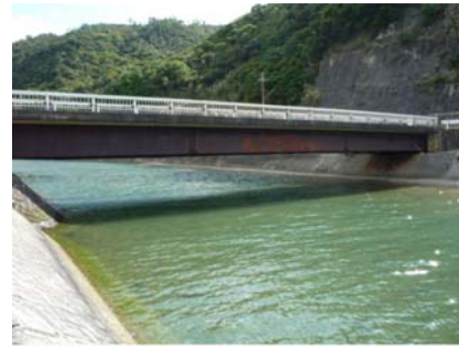
写真 3-1 対象橋梁の全景
