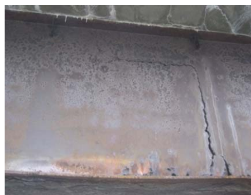
写真 2-8 水平・垂直補剛材の裏面ウェブの破断
