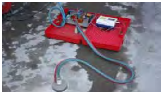
写真-3.14 透気試験実施状況
