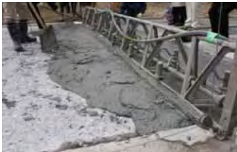
写真-3.13 簡易テンプレートによる敷均し
