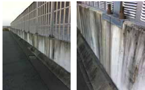
写真-4.6 補修前の壁高欄
