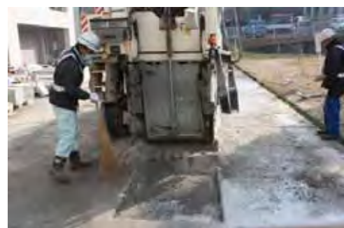
写真-3.11 切削状況
