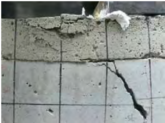
写真-3.5 SFRC 増厚供試体の終局時の状況
