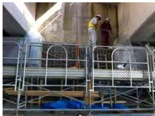
写真-4.3 対象橋梁近景
