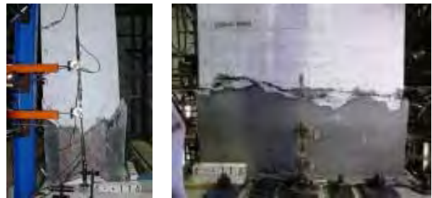
写真-5.10 UHP-SHCC 補修供試体の損傷状況
