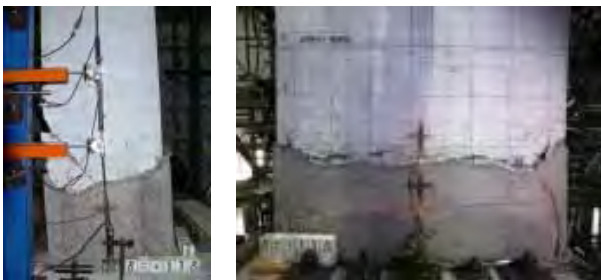
写真-5.8 DFRCC 補修供試体の損傷状況
