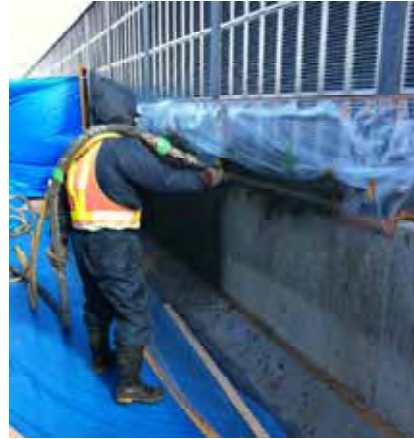
写真-4.9 吹付け状況
