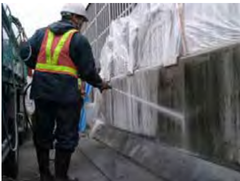
写真-4.8 高圧水による洗浄
