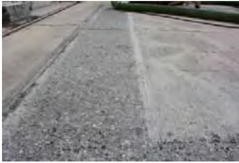
写真-3.12 プラスト処理後の表面
