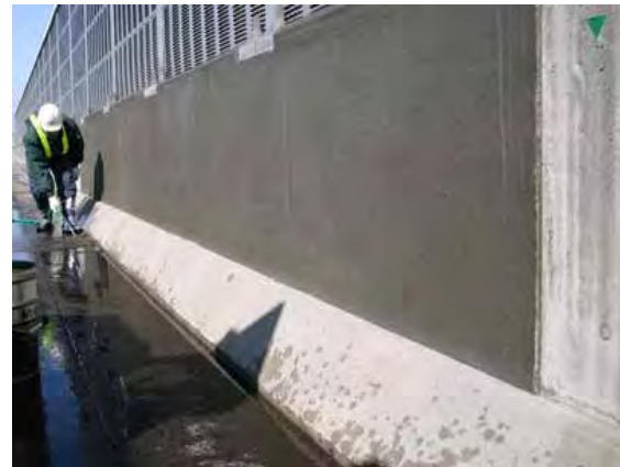
写真-4.10 表面仕上げ終了後
