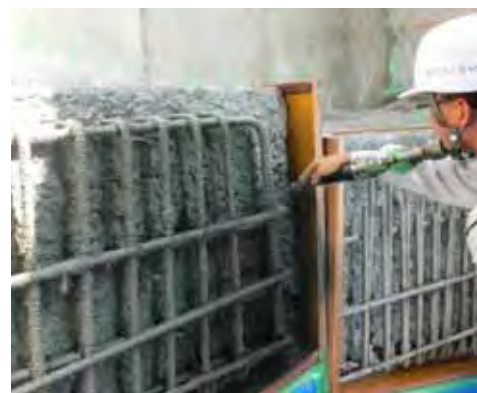
写真-4.4 吹付け状況
