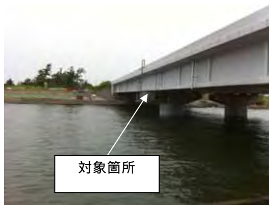
写真-4.2 対象橋梁全景
