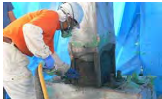
写真-5.3 吹付けの様子
