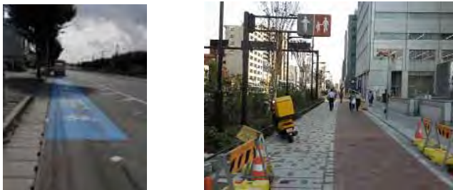
写真3-18 多車線道路での整備事例 （左；盛岡市，右；東京都）
