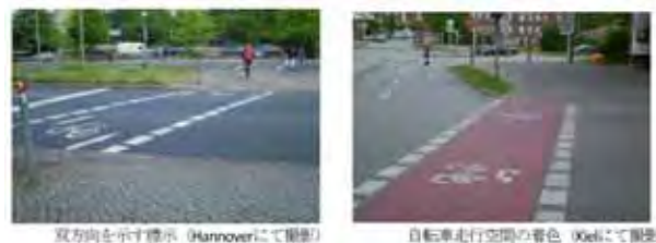
写真3-8 交差点内での注意喚起の工夫 双方向を示す標示（Hannoverにて撮影） 自転車走行空間の着色（Kielにて撮影）
