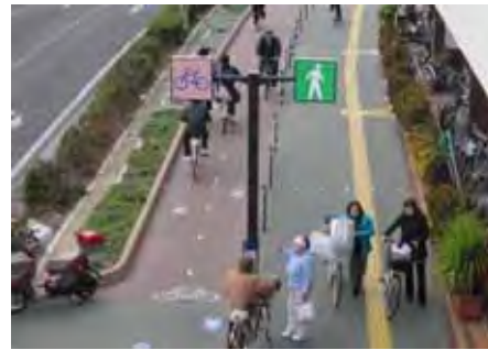
中央線 路面表示 設置後 ( )
