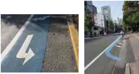
写真3-14 白線または標示で誘導された自転車走行空間（左から宇都宮市，高松市）
