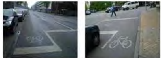
写真3-7 交差点手前における工夫 右折自動車による巻き込み防止（Karlsruheにて撮影） 左折自転車のためのBike Box（Kielにて撮影）
