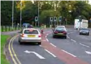
写真3-9 交差点手前で左折自動車と直進自転車が交差した設計事例
