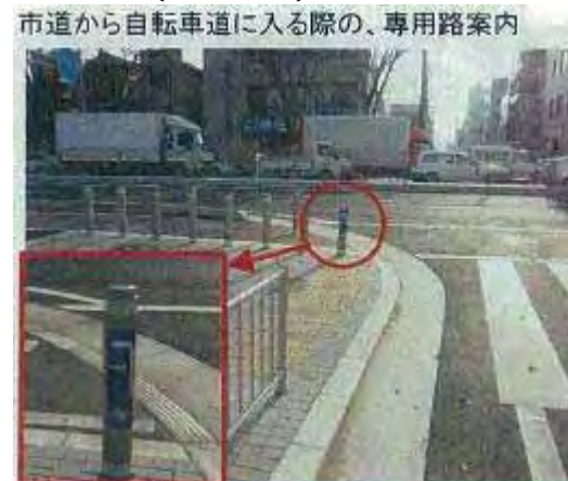
写真3-17 異なる種類の走行空間をつなぐ交差点（相模原市）
