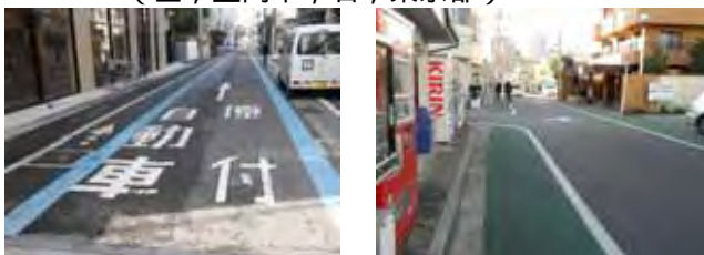
写真3-19 車線道路での整備事例 （左；高松市，右；宇都宮市）
