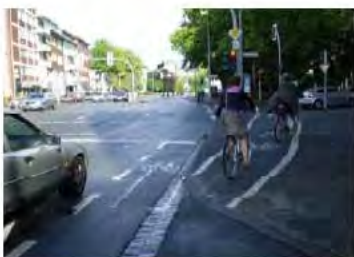
写真3-5 交差点部で自転車を車道から歩道へ上げる事例（M nster にて撮影）
