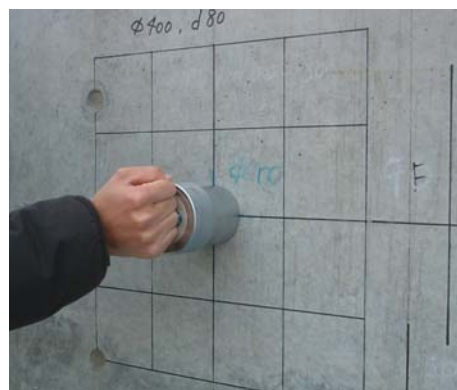
図-2.12 超音波法の計測状況
