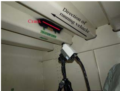
図4.4 測定対象とした溶接部
