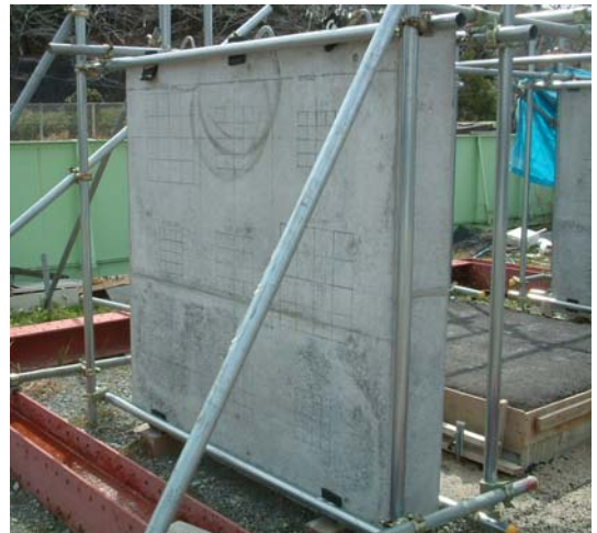
図-2.9 供試体設置状況
