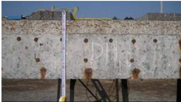
写真-3.6 床版切断面
