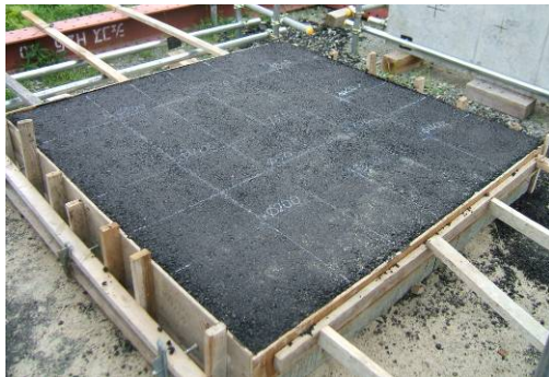
図-2.19 供試体設置状況
