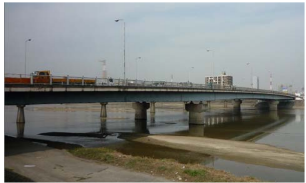
図4.16 測定対象とした鋼橋
