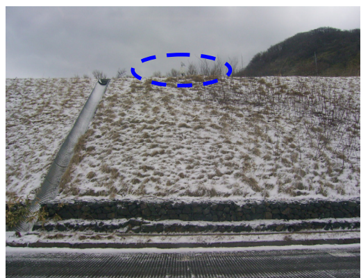
写真-6.1 設置箇所の状況(2010年3月1日)
