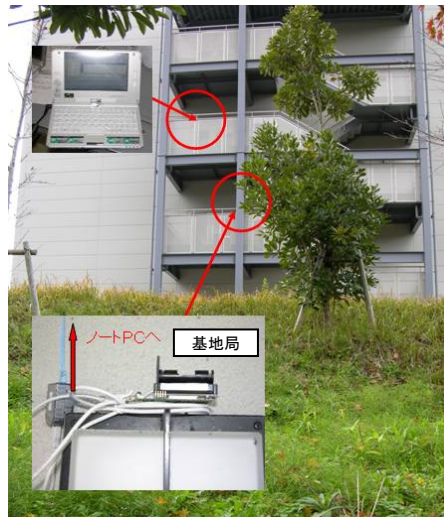
図-2.7 ロガーの設置状況
