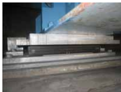
(b) 交換されたゴム支承
