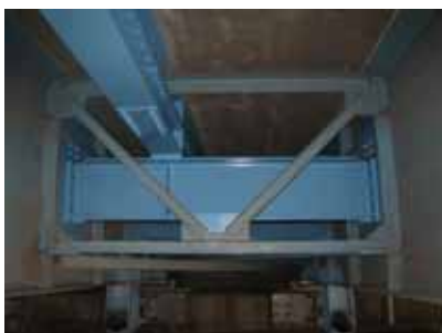
(a) 縦桁・横桁補強
