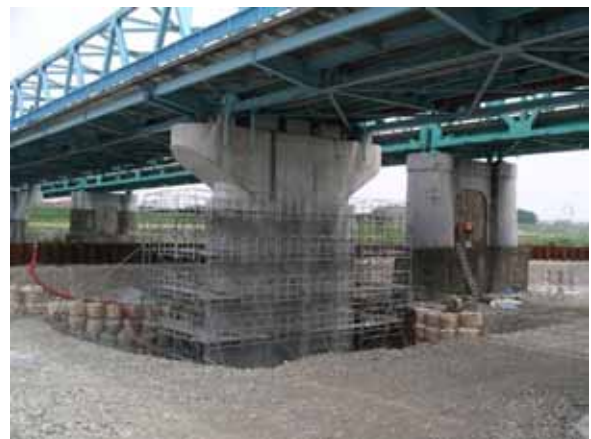
写真 3-31 有沢橋補強工事状況
