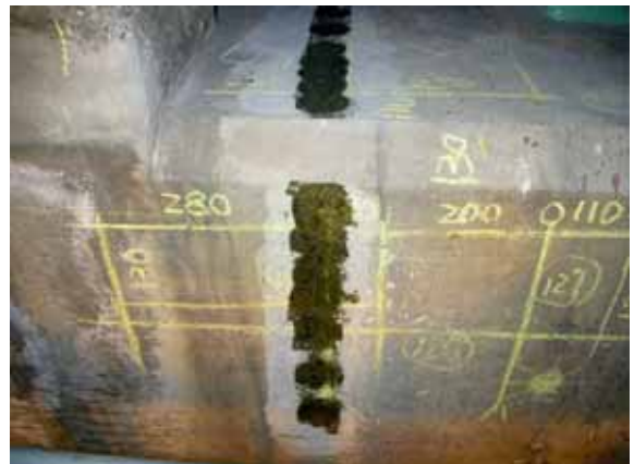
写 3-16 新潟大橋 P6 橋脚
