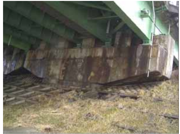
写 3-14 新潟大橋 P6 橋脚
