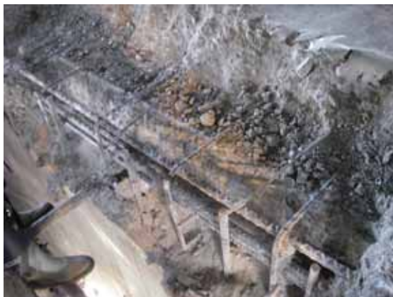
写真 3-33 はつり作業終了後
