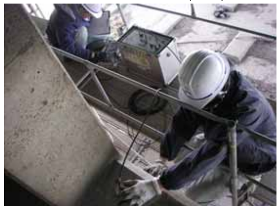
写 3-23 斜角法 測定状況
