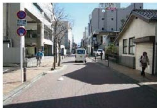
不等幅員車道だったが、走行に支障はなく車にプレッシャーは与えていない。
