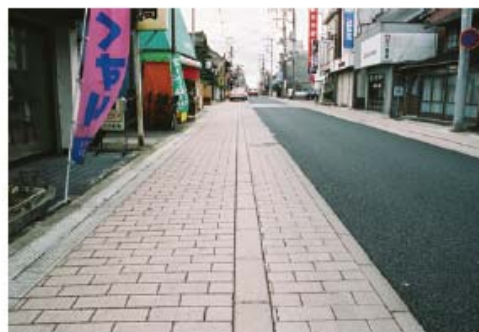
左の路の歩車境部。路側と歩道が同一舗装のため、一層車が狭い印象を受ける。
