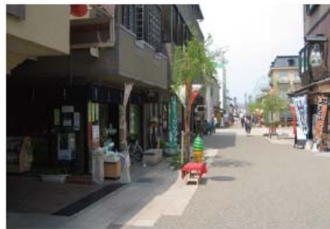
歩道舗装の一部を車道舗装に合わせ、歩道を車道の中に張出しているように見せたもの
