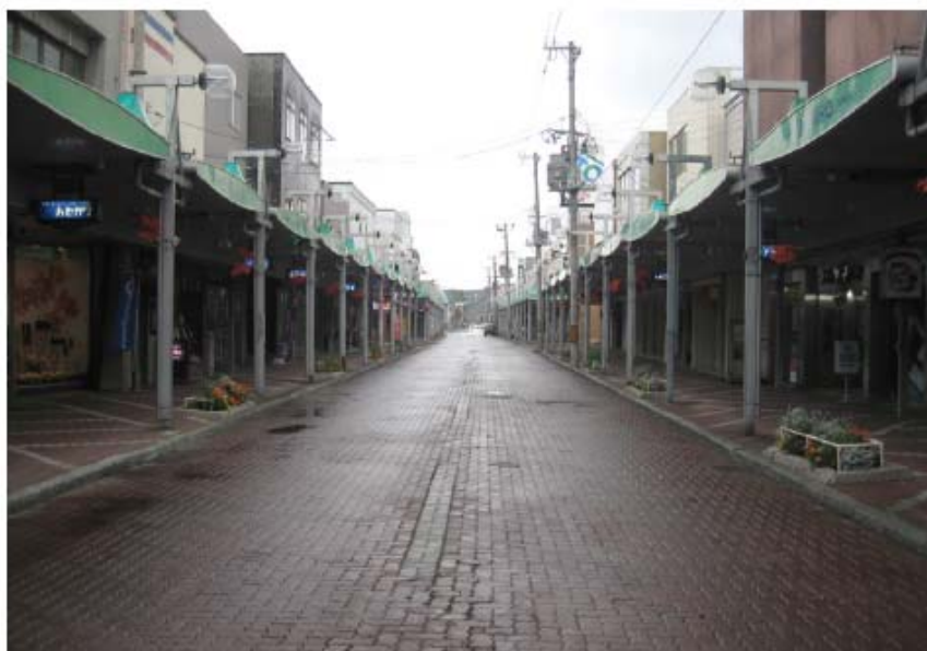
車道のグレードアップ舗装だが、図を作っていない。地では来訪者がもてなされていると感じることが出来ない。
