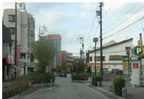
等幅員道路に植栽スペースを張り出し、「車道幅員」を不等幅員にしたもの。
