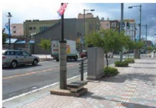
ベンチは一段高い場所に置かれているが、人間が足を置くところは高くなっていない。バリアフリー下での妙な休憩スペース。
