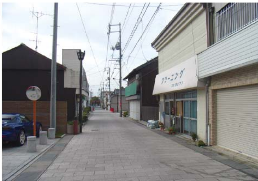
前面石張り舗装。単一材利用はこのように単調となって集客地では人に冷たいことがよくある。
