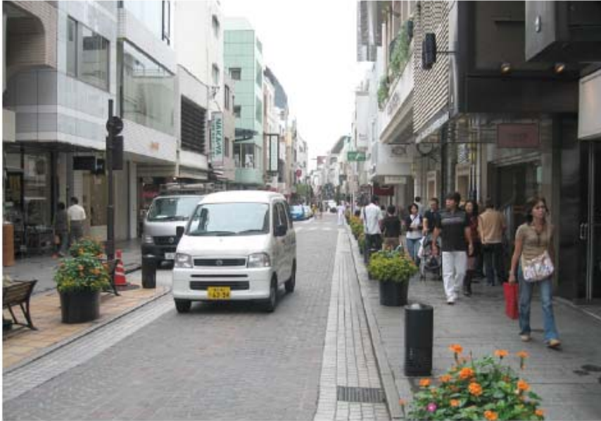
走行車線と路側を分けた舗装。車道、車のためのスペースが狭い印象を受ける。
