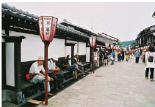
柵にベンチを作りつけたもの。柵の固さを和らげるとともに、ベンチに背を提供している。柵の支壁にも注目。
