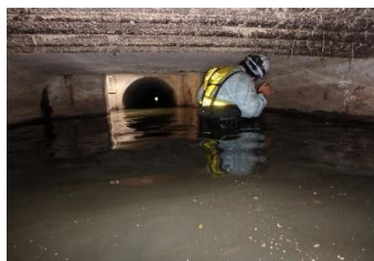
滞水した溝橋内部の目視点検
