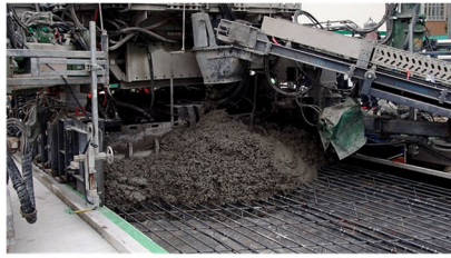
(1) コンクリートの打設
