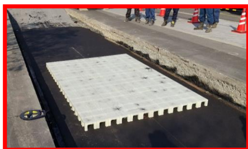
写真3 路床の改良(試験施工Ⅱ)
