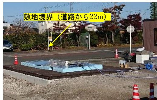
図9 敷地境界の漏えい電磁界測定と高周波利用設備許可状
