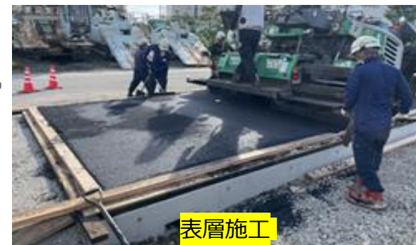
写真2 大型施工機械での施工状況
