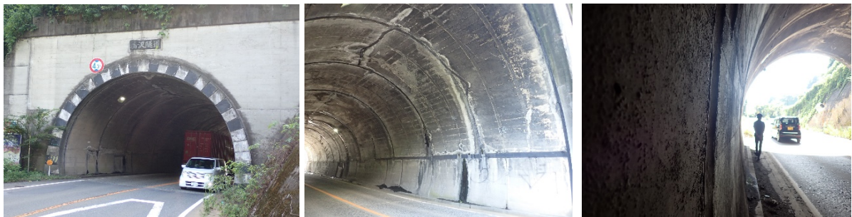
図：橋沢隧道 事前踏査写真
