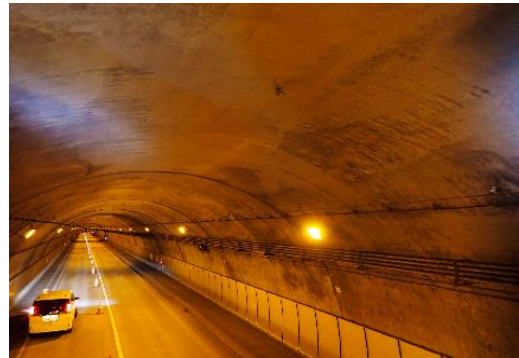
図：生坂トンネル表面の状況
