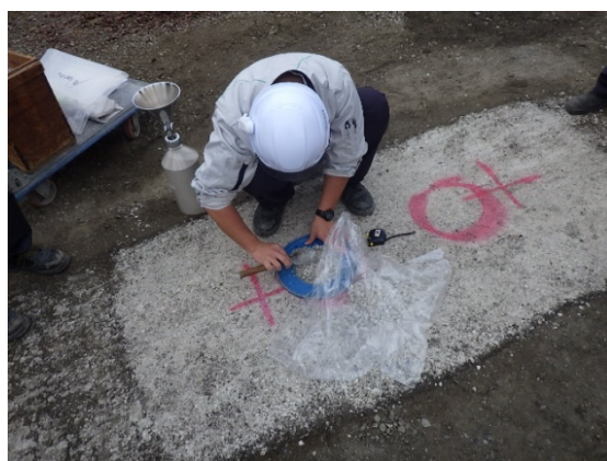
写真 2.3-19 締固め度測定状況
