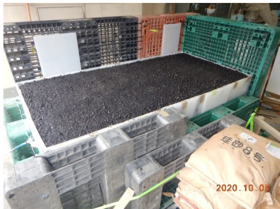
写真1.1-5-4 特殊アスファルト混合物施工
