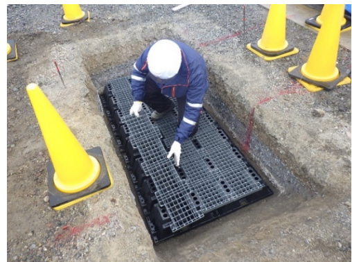
写真 2.3-3 スペーサー設置
