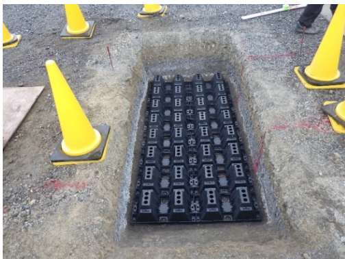
写真 2.3-2 雨水浸透材設置 (1層目)
