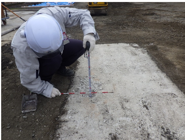
写真 2.3-19 層厚の測定状況
