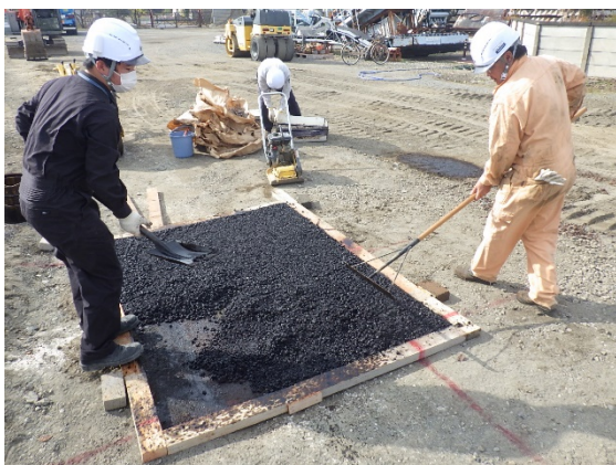
写真 2.3-12 特殊アスファルト混合物敷均し
