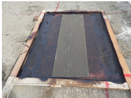
写真 2.3-10 送電電極設置完了
