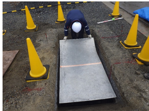
写真 2.3-4 グランド板設置
