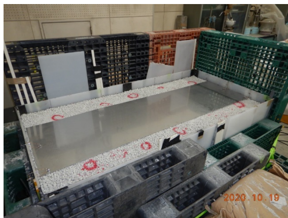
写真1.1-4-3 上層路盤 (セラミック骨材) 施工 および送電電極設置
