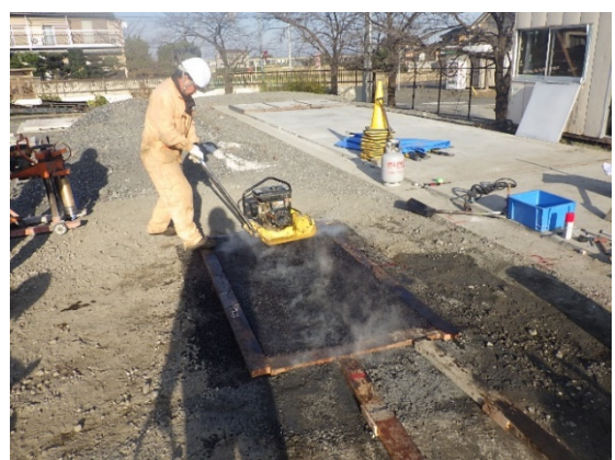
写真 2.3-15 特殊アスファルト混合物転圧 (振動コンパクタ)
