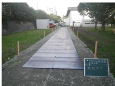
グランド施工
