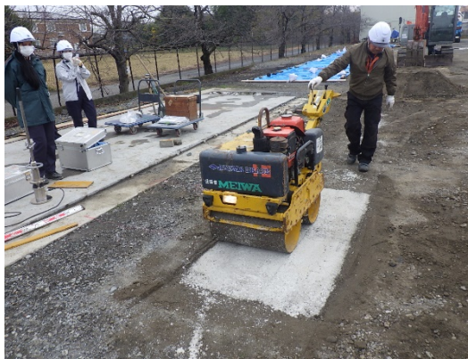
写真 2.3-6 セラミック骨材転圧
