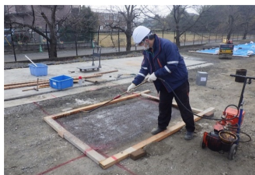
写真 2.3-11 アスファルト乳剤散布
