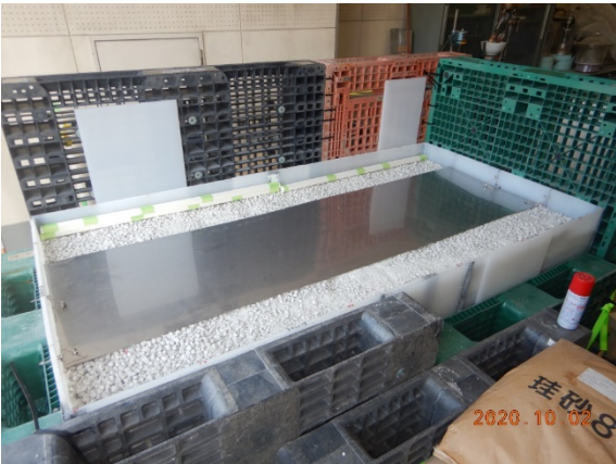
写真1.1-5-3 上層路盤（セラミック骨材）施工 および送電電極設置
