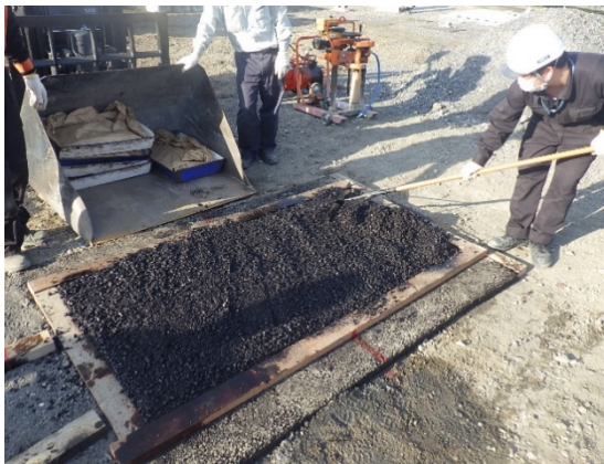
写真 2.3-14 特殊アスファルト混合物敷均し
