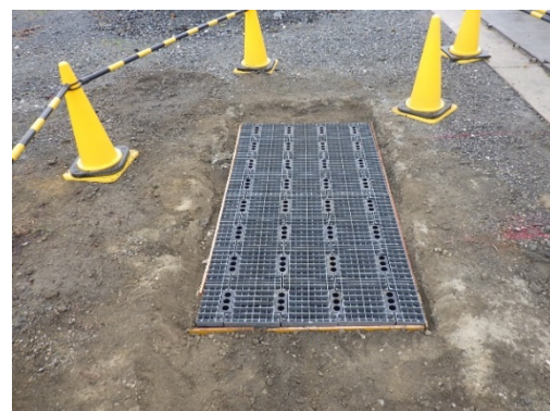
写真 2.3-5 雨水浸透材設置 (2層目)
