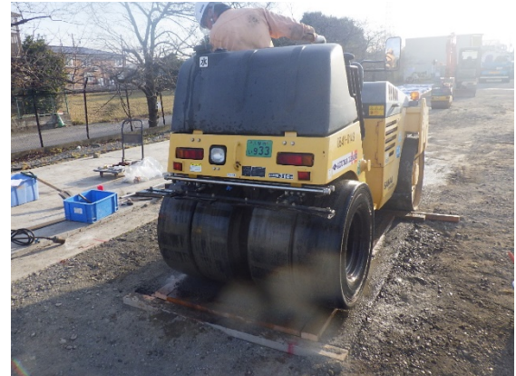
写真 2.3-17 特殊アスファルト混合物転圧 (コンバインドローラ)
