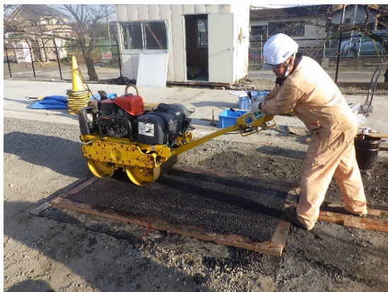
写真 2.3-16 特殊アスファルト混合物転圧 (サイドローラ)
