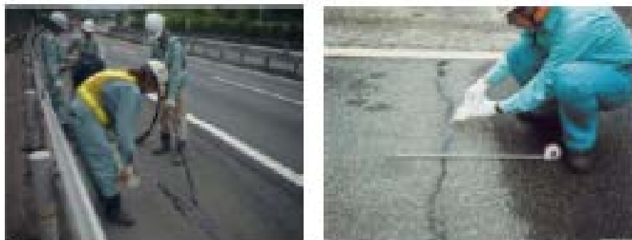
写真 2.4-1 シール材注入工法
