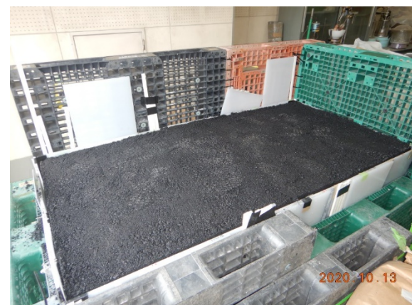
写真1.1-3-4 アスファルト混合物施工
