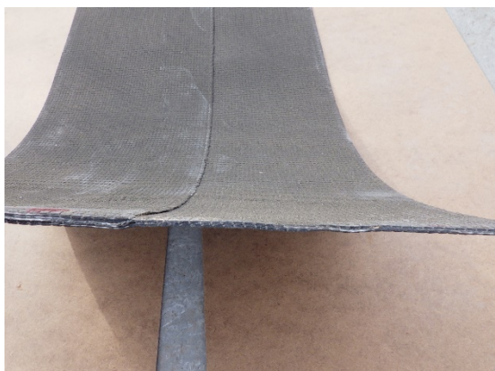
写真 2.3-9 瀝青材貼付完了
