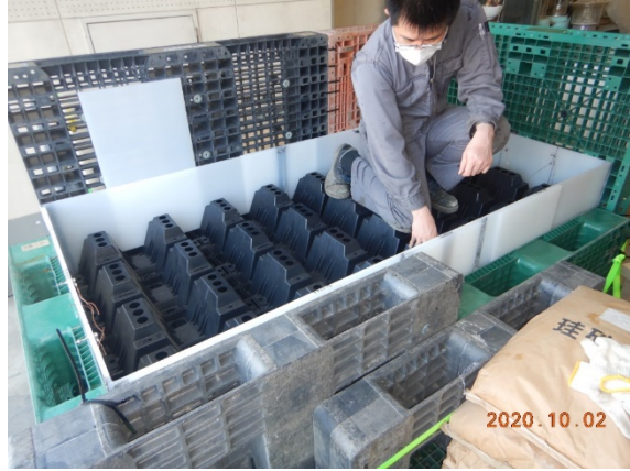
写真1.1-5-2 上層路盤（雨水浸透材）設置
