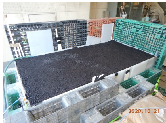
写真1.1-4-4 特殊アスファルト混合物施工
