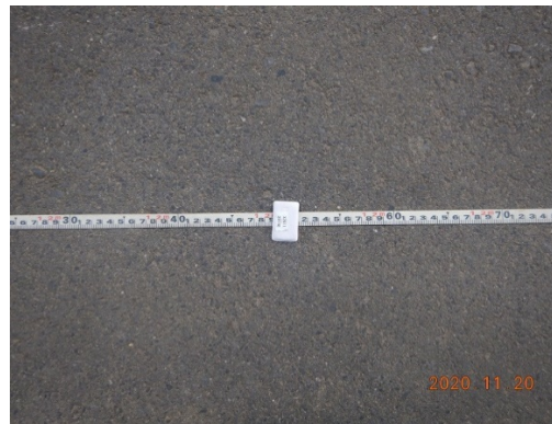
写真 3.1.2-6 タグ路面設置
