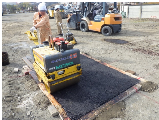
写真 2.3-13 特殊アスファルト混合物転圧
