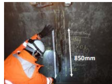
トンネル内現場検証例
